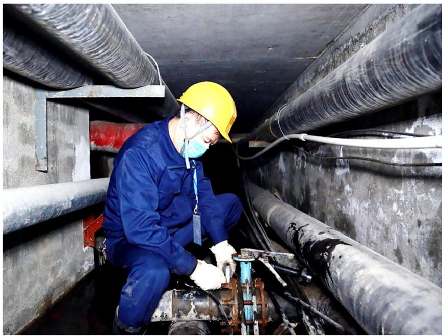
近日,中国铁路西安局集团有限公司安康机务段“党员突击队”队员在井下对供暖热水管道进行检修。
