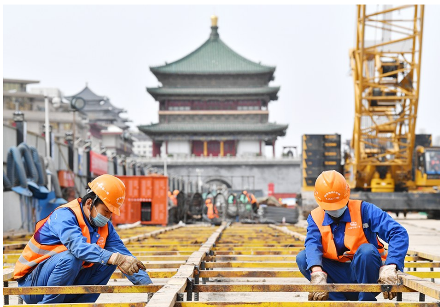
3月9日,工人在西安地铁六号线钟楼站项目施工现场工作。
