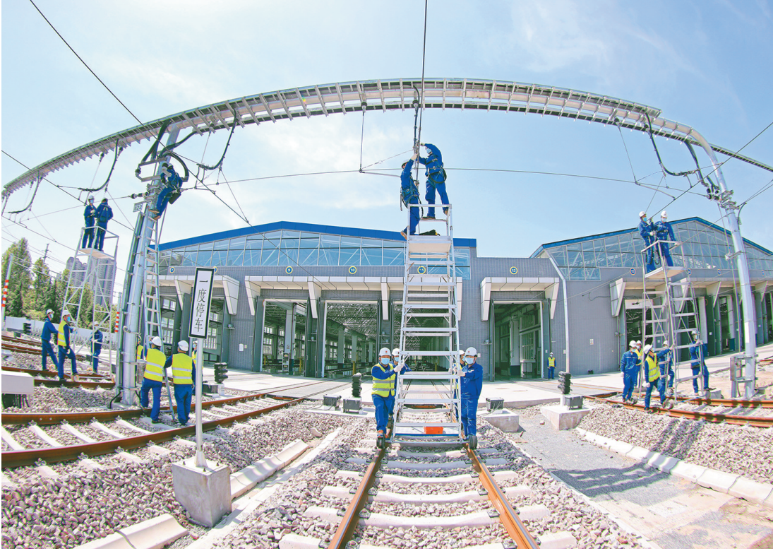
近日,西安市轨道集团运营分公司供电一分部工作人员对1号线西咸车辆段接触网设备进行集中修作业。
