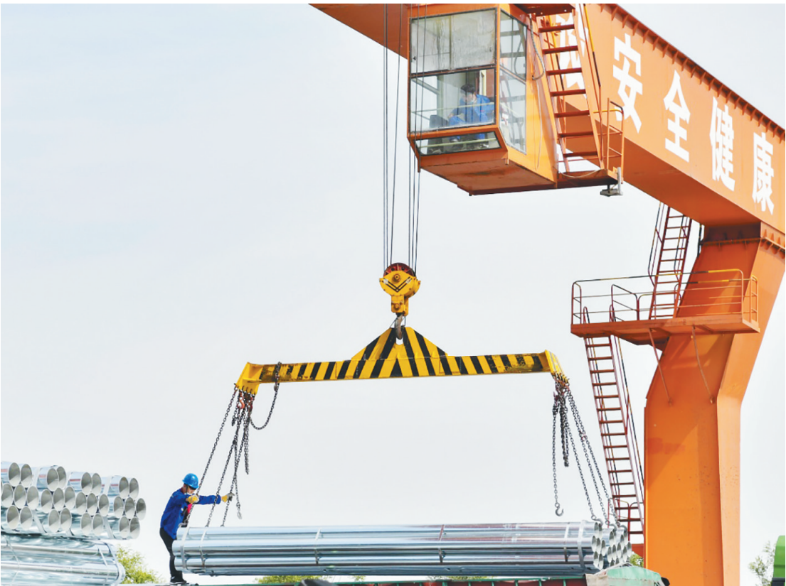
复工复产以来,位于韩城市的陕西友发钢管有限公司一手抓防疫一手抓生产,确保市场供应不断货。图为工人正在吊装产品。 □亢晓丽 摄
