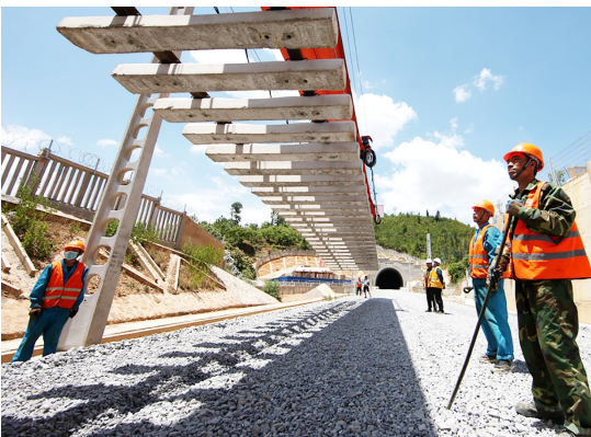
6月3日,经中铁一局新运公司建设者的奋力拼搏,位于云南玉溪市研和镇的中老铁路国内玉磨段铺轨施工现场,最后一节轨排安全平稳落地,铺轨通过玉溪至磨憨段第一座全长944米研和隧道。
