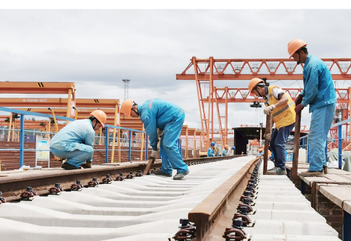
7月22日,工人在轨排生产线上组装轨排。在中老昆万铁路国内玉磨段的中铁一局研和铺架基地,项目部在工期紧、任务重、质量要求高的情况下,精心组织,合理安排,顶风冒雨奋战在施工一线。 刘顺良 摄
