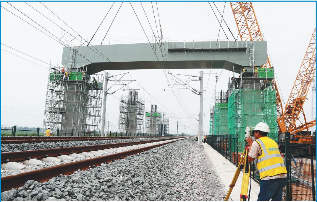
近日,在咸阳市乾县境内的西(安)法(门寺)北城际铁路乾县特大桥工地,随着重约99吨的钢箱梁顺利吊装到位,中铁电气化局铁路工程公司承建的东西法北城际铁路乾县右线特大桥跨西银高铁门式墩盖梁钢模板首架成功,这标志着西法北城际铁路建设取得重大进展。
